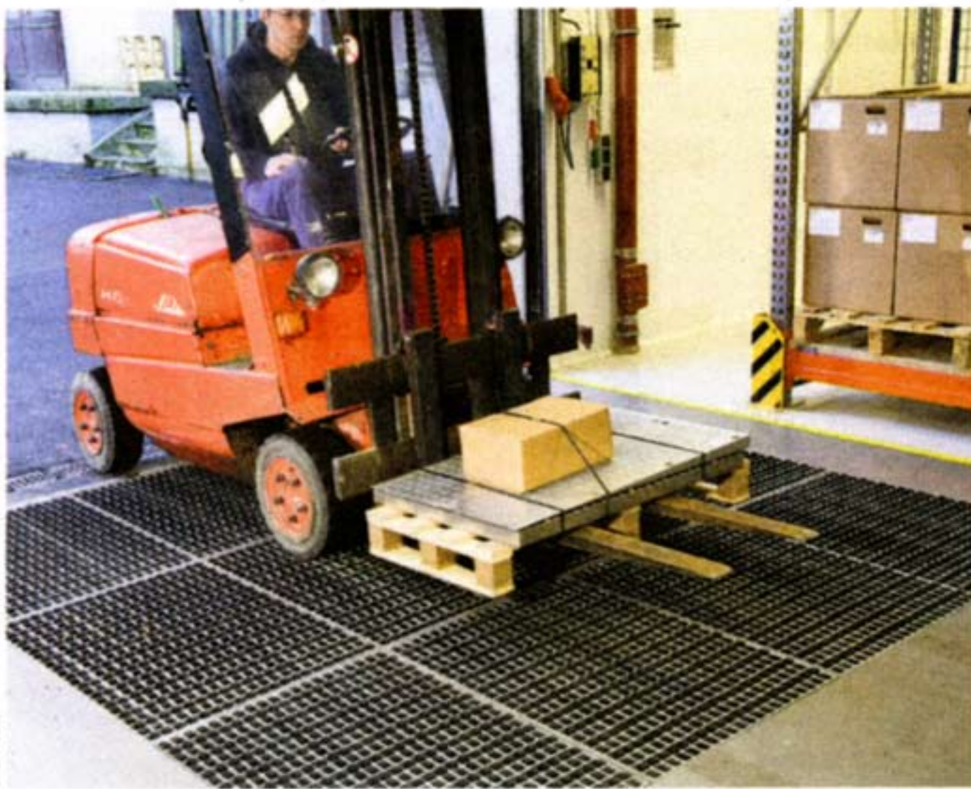
Die Reinigungsfelder können auch nachträglich installiert werden.
